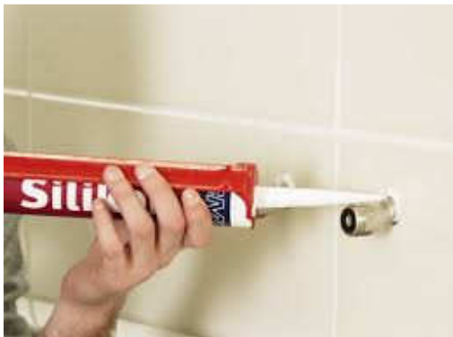
Nieuw kitwerk aanbrengen achter rozetten
